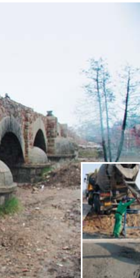
Die historische Brückenkonstruktion Nr. 018 bei Kobylnice an der Fahrstraße I/2 wurde mit einem Leichtbeton der Klasse LC 16/18 D1,4 saniert.
