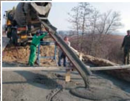
Die historische Brückenkonstruktion Nr. 018 bei Kobylnice an der Fahrstraße I/2 wurde mit einem Leichtbeton der Klasse LC 16/18 D1,4 saniert.
