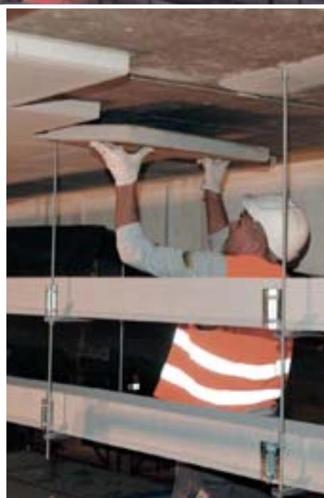
Das Reapor-System zum Kleben löste viele Anforderungen: Schallschutz, Brandschutz, Wind-/Sogbelastung und Ästhetik.
