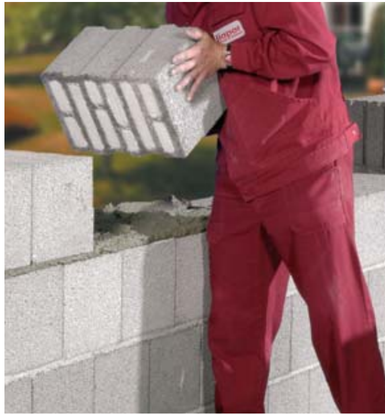
Der innovative, hoch wärmedämmende Liapor SL wird mit der Füllung nach unten vermauert.
