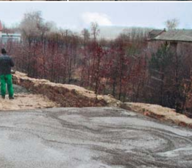
Der Liapor-Leichtbeton dient als Ausgleichs- und Füllschicht für die vorhandenen Gewölbe.
