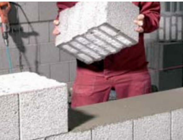
Das Kleben der Plansteinvariante zeichnet sich durch einen besonders geringen Mörtelverbrauch aus.
