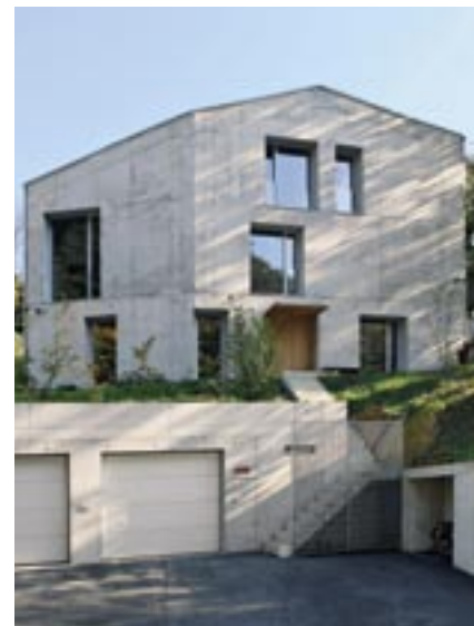
Die „Wohnhöhle“ gräbt sich tief in den Hang.
