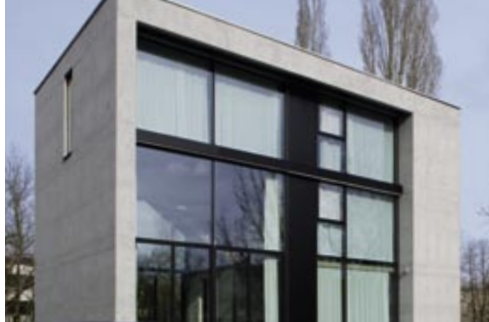
Monolithisch mit Infraleichtbeton gebaut: Bei einer Trockenrohddichte von 760 \text{ kg/m}^3 erreichen die Wände einen berechneten U-Wert von 0,34 \text{ W/(m}^2 \text{ K)} .
