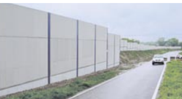
Ein absolut ökologisches Produkt: Lärmschutzwand aus Reapor an der neuen Ortsumgehung in Leimen.
