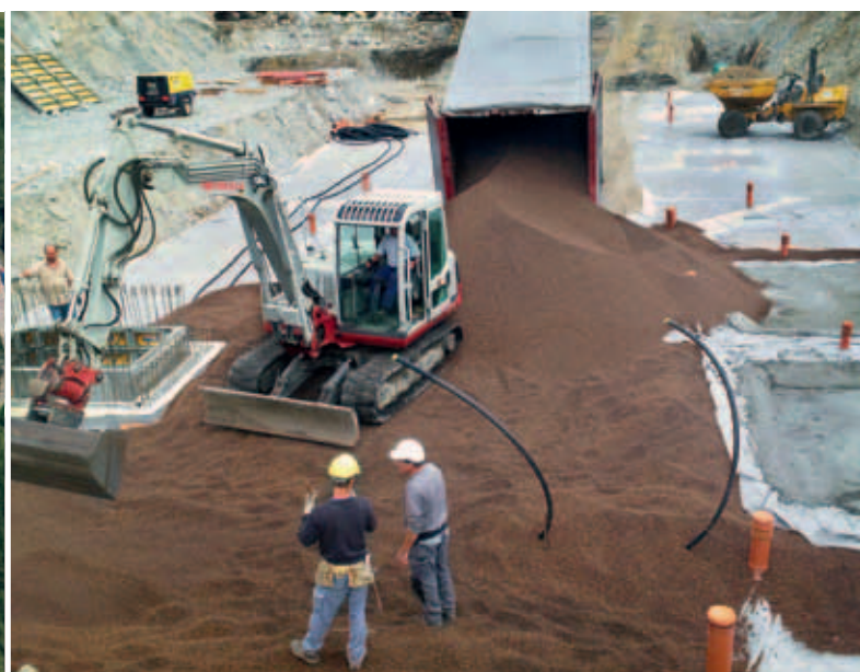
Der Eintrag der Perimeter-Dämmung erfolgte passgenau um die Sanitär- und Abwasserinstallationen herum.
