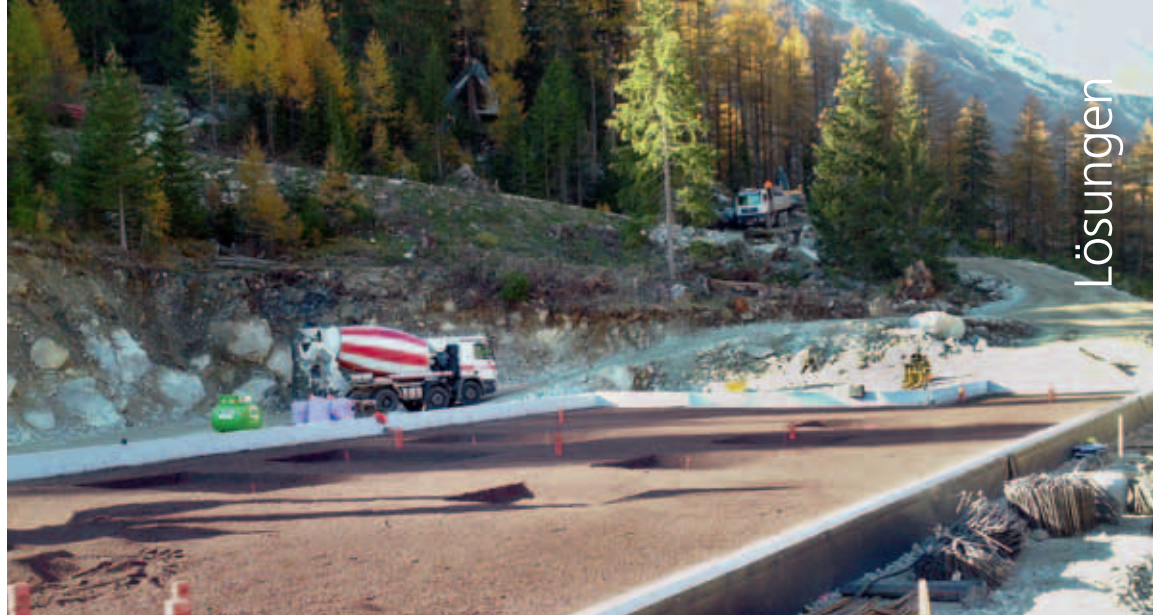
Rund 1.500 m 3 Liapor Ground sorgen unter der Bodenplatte des Hotels für Stabilität und Wärmedämmung.
