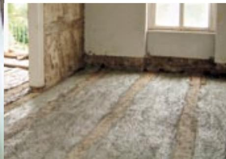
*Eine Kalk-Zement-Schlämme verfestigte die oberste Liapor-Schicht, um die Schalldämmwerte weiter zu verbessern.*
