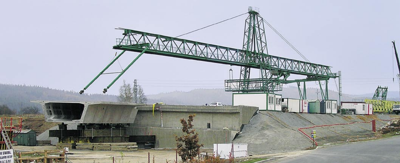
Grundschwellen für den Kran: Fundamentblöcke aus Liapor-Leichtbeton.
