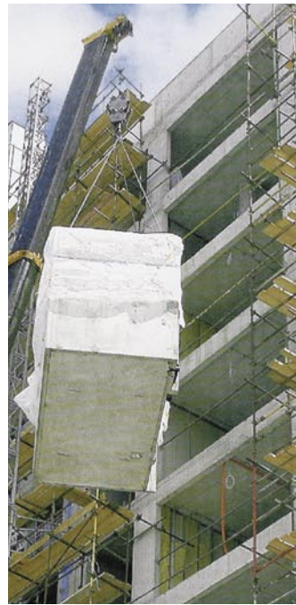
Deutlich verkürzte Bauzeiten durch VARIS-Leichtbaubäder.
