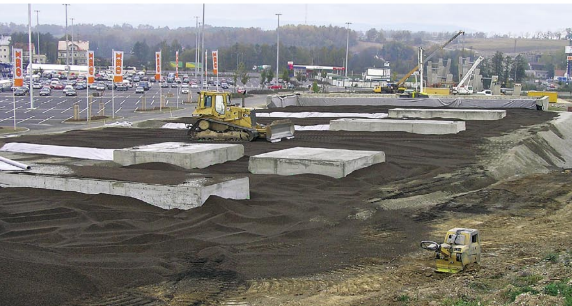
Die mit ca. 5.500 m 3 bisher größte Liapor-Geoschüttung in Tschechien kam beim Bau der Autobahn I/6 (E48) in Karlsbad-West zum Einsatz.
