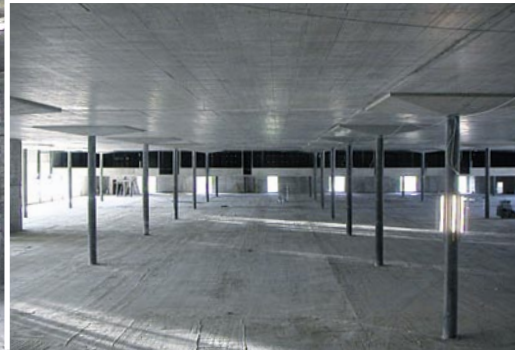
Hightech-Betonstützen erlauben einen Stützraster von 16 mal 14,5 Metern.
