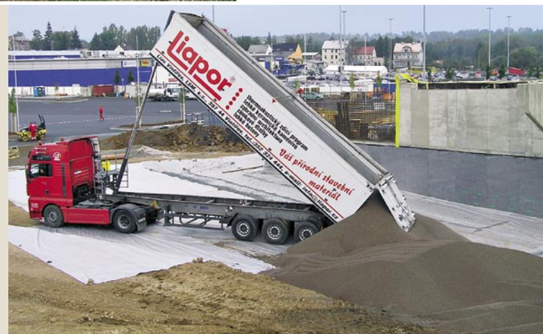
Die mit ca. 5.500 m 3 bisher größte Liapor-Geoschüttung in Tschechien kam beim Bau der Autobahn I/6 (E48) in Karlsbad-West zum Einsatz.
