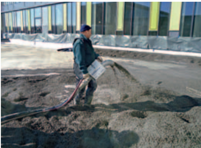
Die Liapor-Schüttung ließ sich dank des Kneißl-Systems in nur drei Tagen aufbringen.
