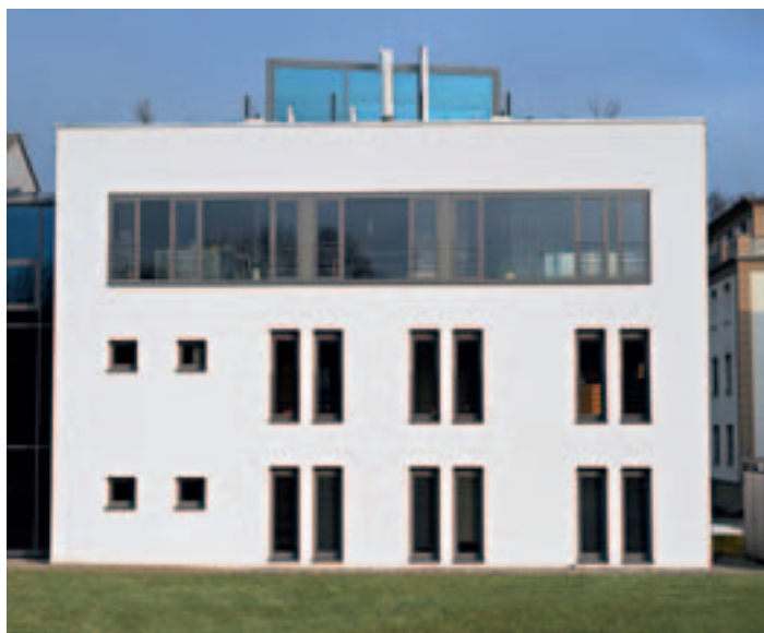
Die Massivbauweise mit Liapor-Mauersteinen erfüllte alle Vorgaben bezüglich Wärmedämmung, Schallschutz und Raumklima optimal.
