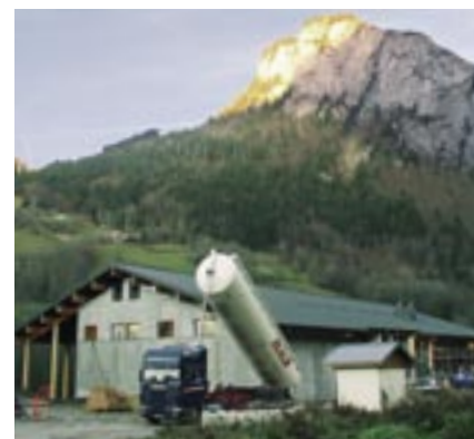
Kläranlage im Skigebiet Abondance in den französischen Alpen.
