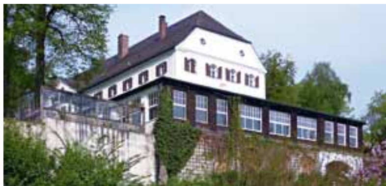
Das Schlosshotel Herrenchiemsee wird zurzeit umfassend instand gesetzt.
