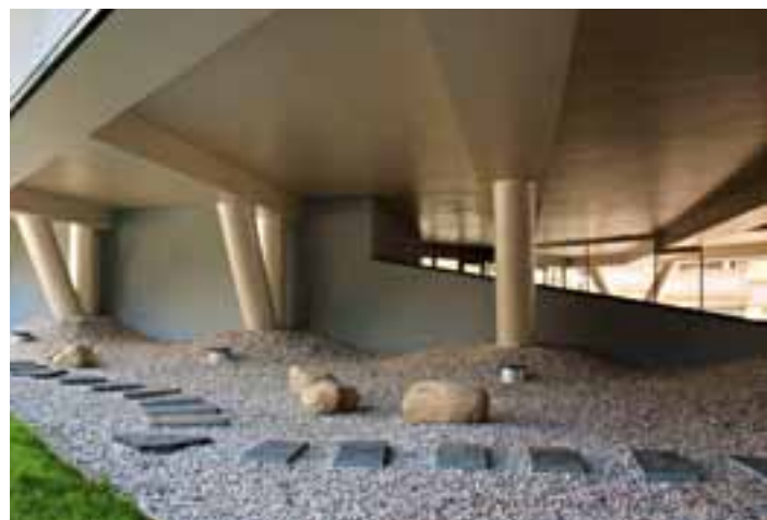
Stützen unter dem Gebäude gleichen das vorhandene Gefälle aus.
