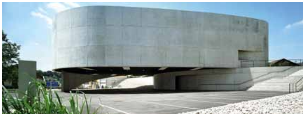
Zwei Drittel des weit auskragenden Gebäudes werden nur von einem einzigen exzentrischen Punkt gestützt.
