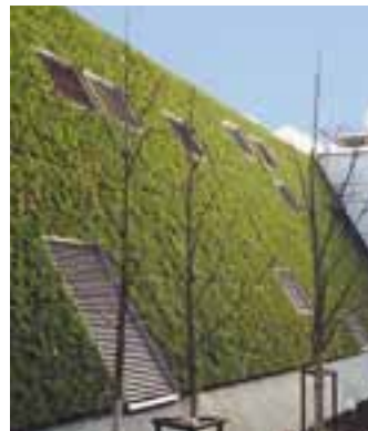
Die Begrünung der Steildachflächen erfolgte mit Raster-Elementen.
