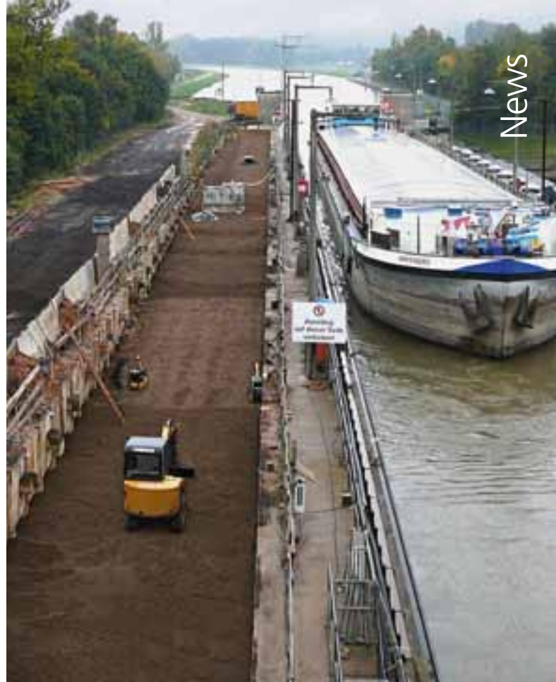
Die Hinterfüllung der Kammerwand wurde durch Liapor-Blähtonkörnung ersetzt, die damit für einen sicheren Massenausgleich sorgt.
