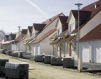
Fertigteile mit Liapor-Blähton erfüllen die hohen Anforderungen an die Wirtschaftlichkeit des Projekts.
