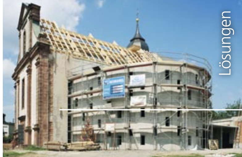
Während der Sanierung: die St.-Valentins-Kirche in Limbach.
