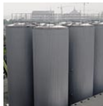
Analog einer „verlorenen Schalung“: Behälter, die temporär mit Liapor gefüllt werden.
