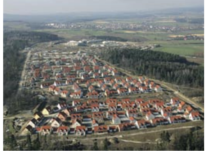
830 Häuser errichtet die fränkische ZAPF GmbH in der Netzaberg Housing Area.
