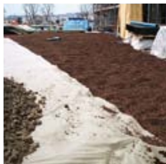
Ein Schutzvlies trennt die im Mittel rund 15 Zentimeter mächtige Liadrain-Schicht von der darüberliegenden Substratschicht.
