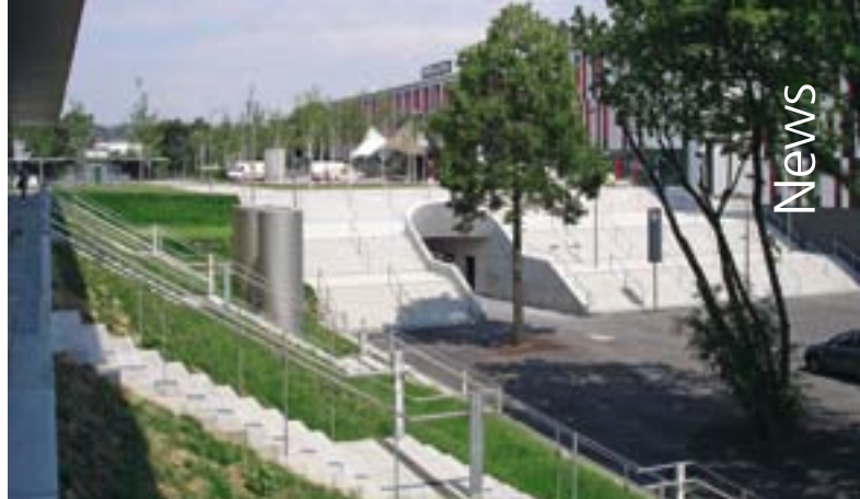
Das Areal vor dem Carl Benz Center wurde als durchgängig intensive Dachbegrünung über der Tiefgarage gestaltet.
