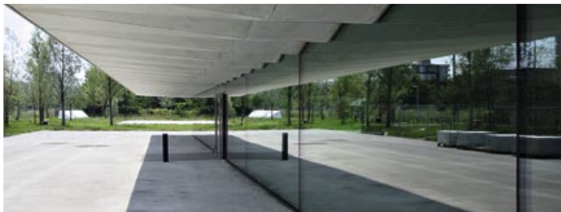
Die bis zu zehn Meter ausragenden Balkone aus Liapor-Leichtbeton strukturieren die Gebäudehülle.
