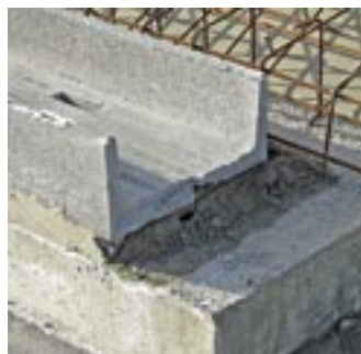
Die rund 741 Meter langen Unterbauten der Kabelkanäle bestehen aus Liapor-Leichtbeton.
