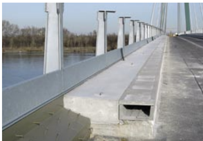
Die rund 741 Meter langen Unterbauten der Kabelkanäle bestehen aus Liapor-Leichtbeton.
