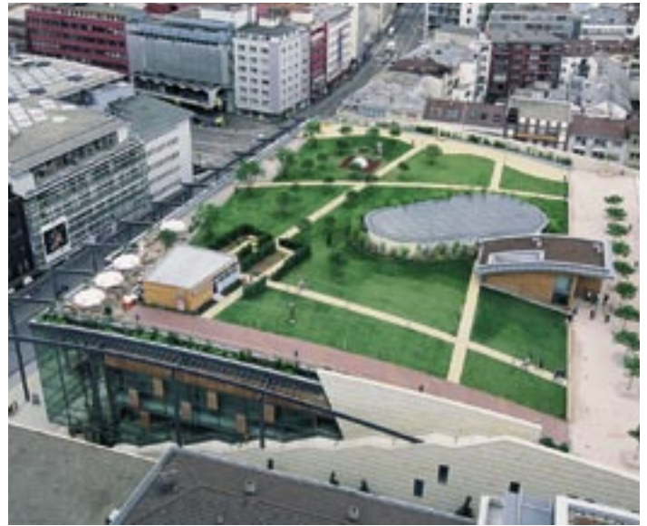
Auf dem Dach der Schlössle-Galerie wächst eine grüne Oase heran. Für einen stabilen Untergrund sorgt Liadrain-Blähtonsubstrat.
