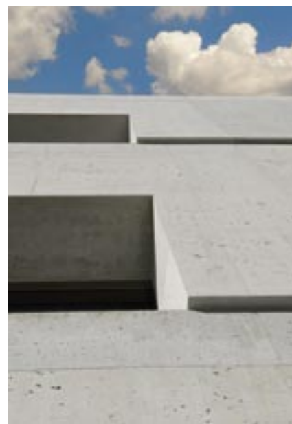
Schmale Mauervorsprünge setzen die einzelnen Etagen des dreigeschossigen Gebäudes leicht voneinander ab.
