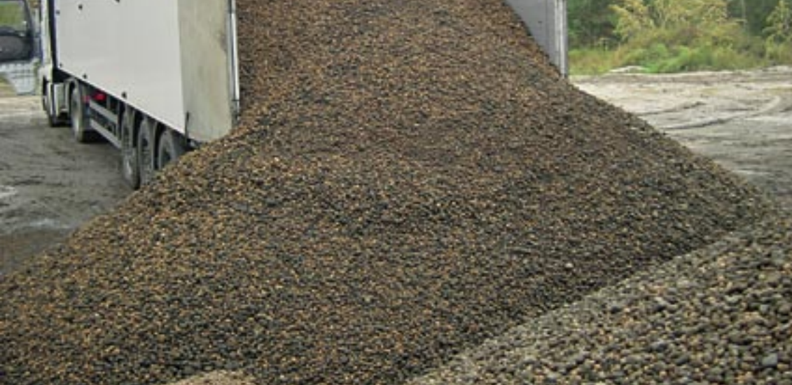
Der vorhandene Abraum-boden wurde durch Liapor-Blähtonkörnung ersetzt. Ein Vlies verhindert das Eindringen von Partikeln in den Liapor-Schüttkörper.
