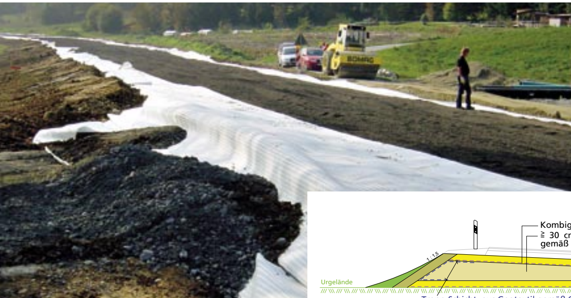
Damm über das Laufinger Moor: 17.000 \text{ m}^3 Liapor-Blähtonkörnung dienen als Aufschüttung.
