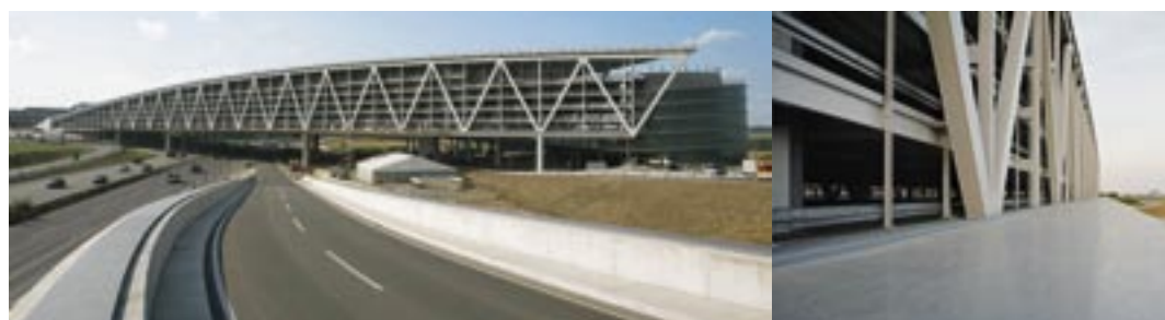
Gewichtsreduzierte Kragplatten aus Liapor-Leichtbeton.
