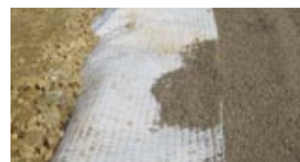
Damm über das Laufinger Moor: 17.000 \text{ m}^3 Liapor-Blähtonkörnung dienen als Aufschüttung.
