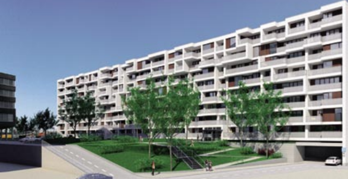
Auf dem Postareal am Salzburger Hauptbahnhof entsteht mit 104 Einheiten Österreichs größtes Energiesparhaus.
