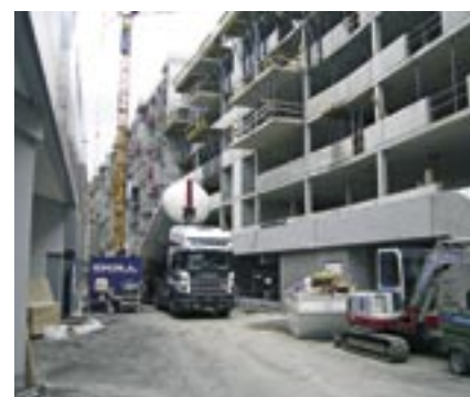
Gerade bei engen Baustellen in Großstädten bieten die Anlieferung und Verarbeitung mittels Silozug und Schlauchleitung optimale Flexibilität.
