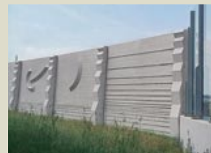
Die lärmabgewandte Seite der Lärmschutzwände kann auf vielfältige Weise künstlerisch gestaltet werden.
