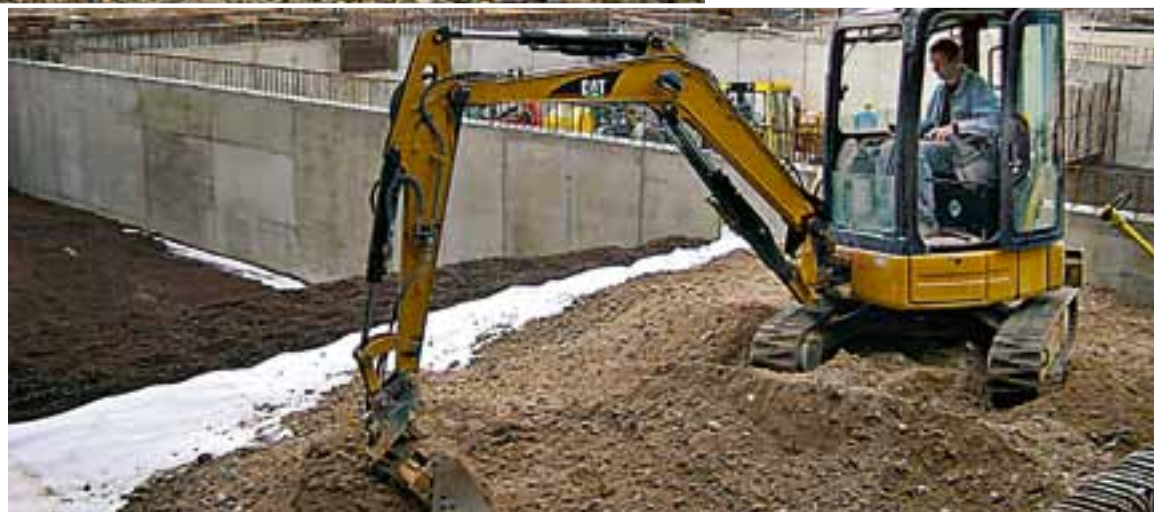
Der vorhandene Abraum-boden wurde durch Liapor-Blähtonkörnung ersetzt. Ein Vlies verhindert das Eindringen von Partikeln in den Liapor-Schüttkörper.
