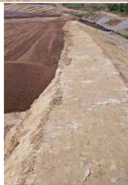
Bis zu elf Meter hoch ist der lagenweise eingebrachte Liapor-Straßendamm, der beidseitig von Erdwällen eingefasst wird.
