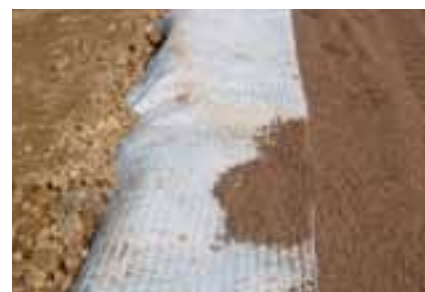
Damm über das Laufinger Moos: 17.000 \text{ m}^3 Liapor-Blähtonkörnung dienen als Aufschüttung.
