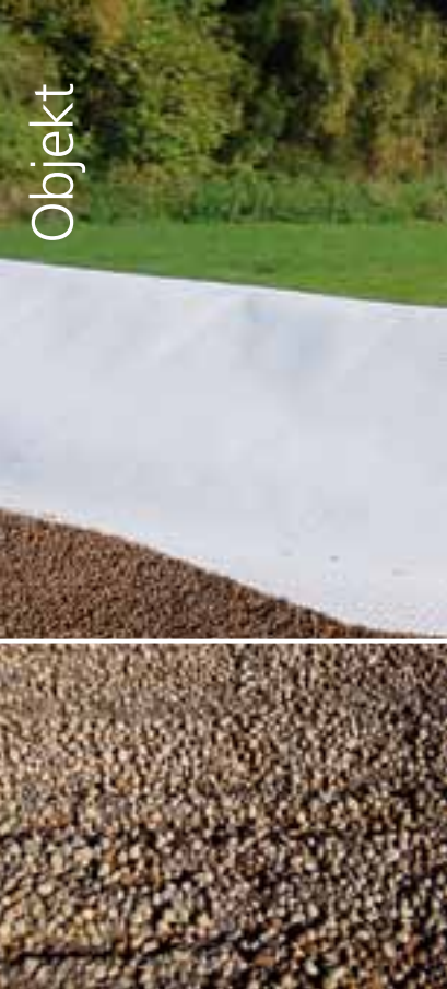
Liapor-Blähtonkörnungen bieten die ideale Lösung bei wenig tragfähigen Untergründen wie dem Laufinger Moos.
