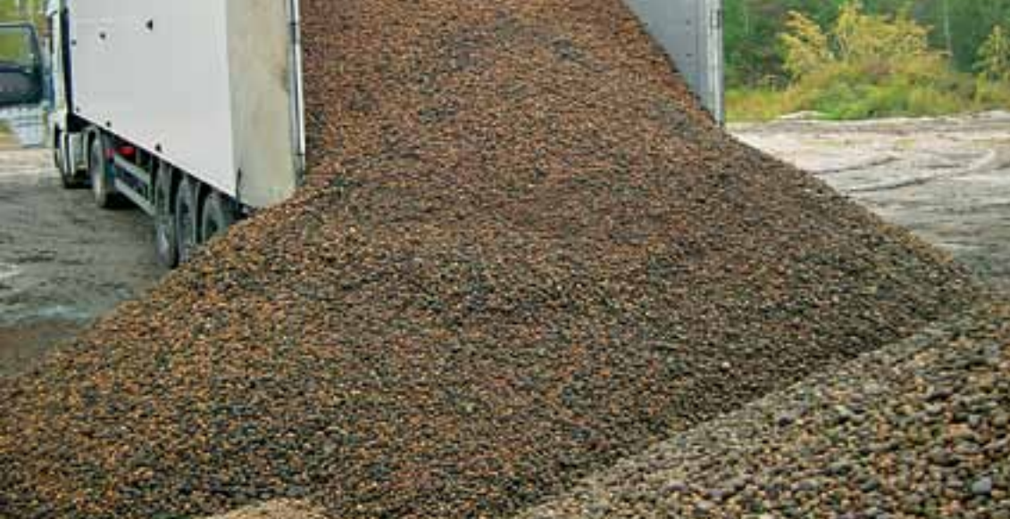
Der vorhandene Abraum-boden wurde durch Liapor-Blähtonkörnung ersetzt. Ein Vlies verhindert das Eindringen von Partikeln in den Liapor-Schüttkörper.
