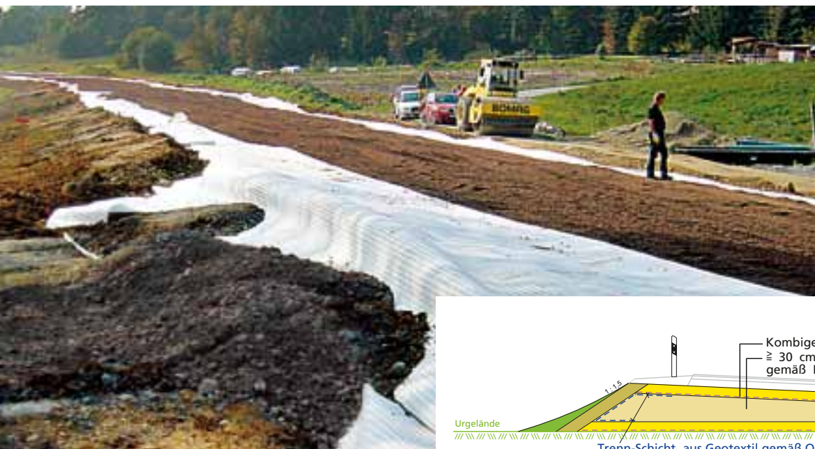
Damm über das Laufinger Moos: 17.000 \text{ m}^3 Liapor-Blähtonkörnung dienen als Aufschüttung.
