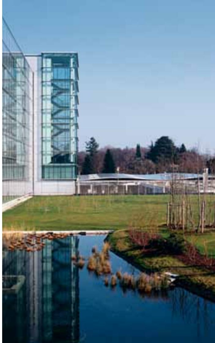
Schutz- und Speicher-Vlies verlegt. Darauf kamen eine zehn Zentimeter hohe Drainschicht Liapor, dann ein Filter-Vlies. Die letzte Schicht in der Höhe von 30 Zentimetern besteht aus Rasen sowie Intensivsubstrat. Heute zieren eine Kräutertwiese und zwei Areale mit Hunderten flach wachsenden Kiefern und Zierjohannesbeersträuchern die weitläufigen Grünflächen.
