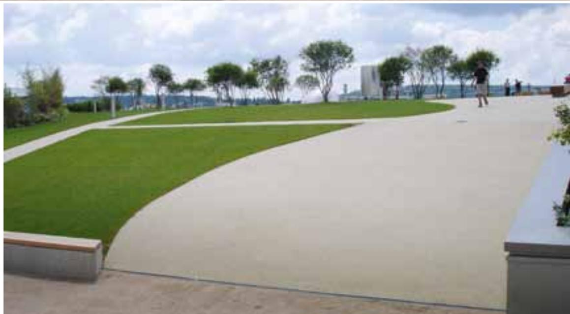
werden konnten. Auf diese Weise ließ sich eine umständliche Beförderung per Kran oder Lastenaufzug tungehen. Dank des geringen Gewichts von 325 Kilogramm pro Kubikmeter wurden die rund 1.600 Kubikmeter Liadrain der Körnung 2/10 innerhalb von drei Monaten in Etappen mit 40 Kubikmetern pro Stunde direkt vom Silozug mit einem Schlauch auf das Flachdach geblasen. Ende 2005 war
