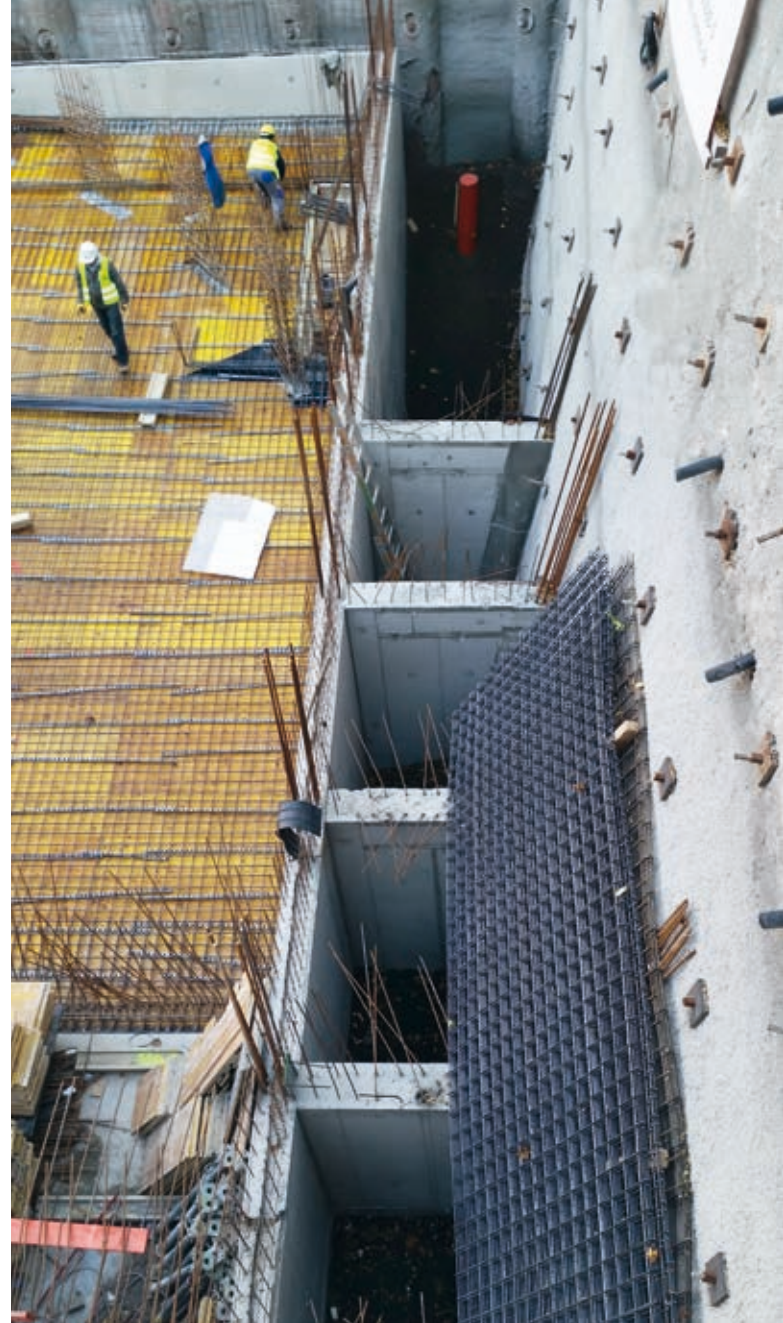
Die druckfeste und formstabile Liapor-Hinterfüllung verringert den Umgebungsdruck auf das Gebäude.
