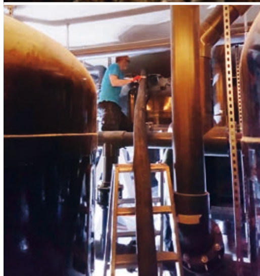
Per Schlauchleitung wurden die Filterbehälter des Aquariums mit Liaperl befüllt.
