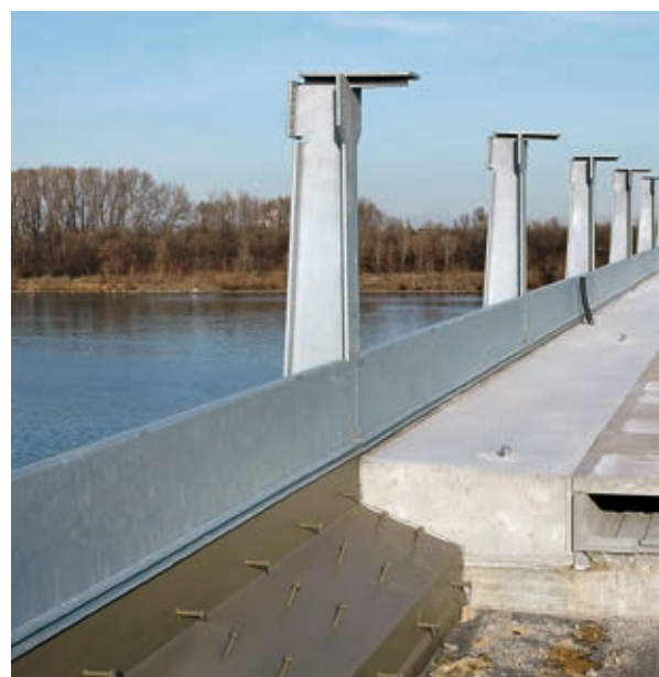
Beim Brückenausbau wie in Wien (rechts) und Budapest (ganz rechts) sorgt Liapor-Leichtbeton für signifikante Gewichtsreduktionen.
