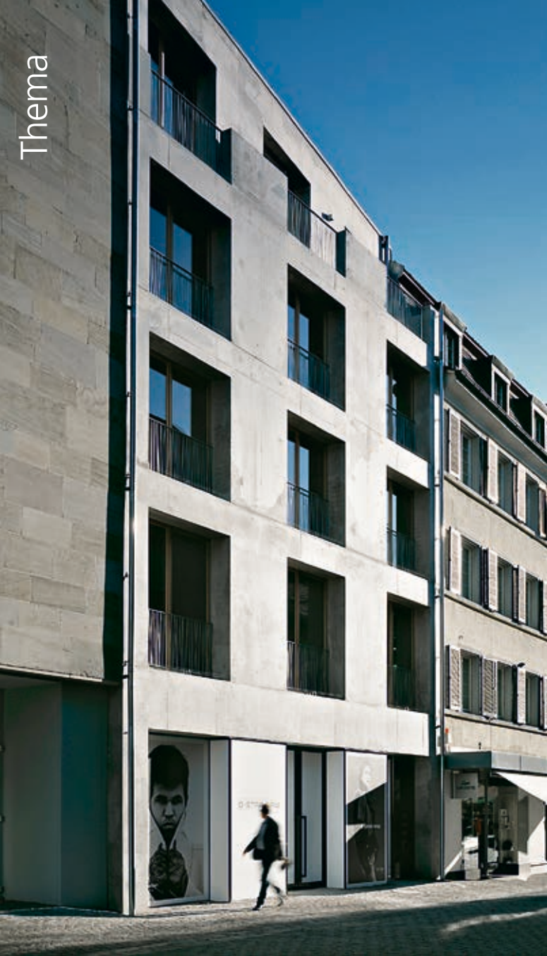
Konstanzer Lückenfüllung: Die Ausführung in Liapor-Leichtbeton spielt auf die Einfachheit der Umgebung an, unterstreicht aber auch den Rhythmus der Fassaden.
