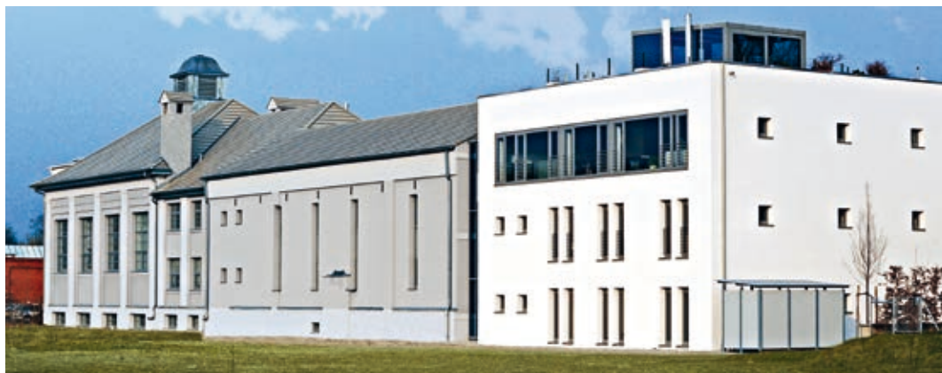
Behutsame Fortführung in Augsburg: Der moderne Anbau steht in harmonischer Relation zur angrenzenden, denkmalgeschützten Maschinenhalle.
