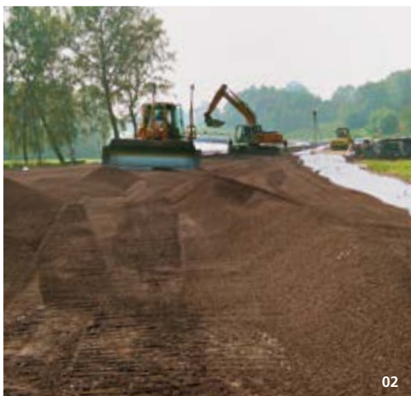
02 Bei der Umfahrung Ebersberg sichert die Liapor-Schüttung die Tragfähigkeit auf weichen Moorsedimenten.
