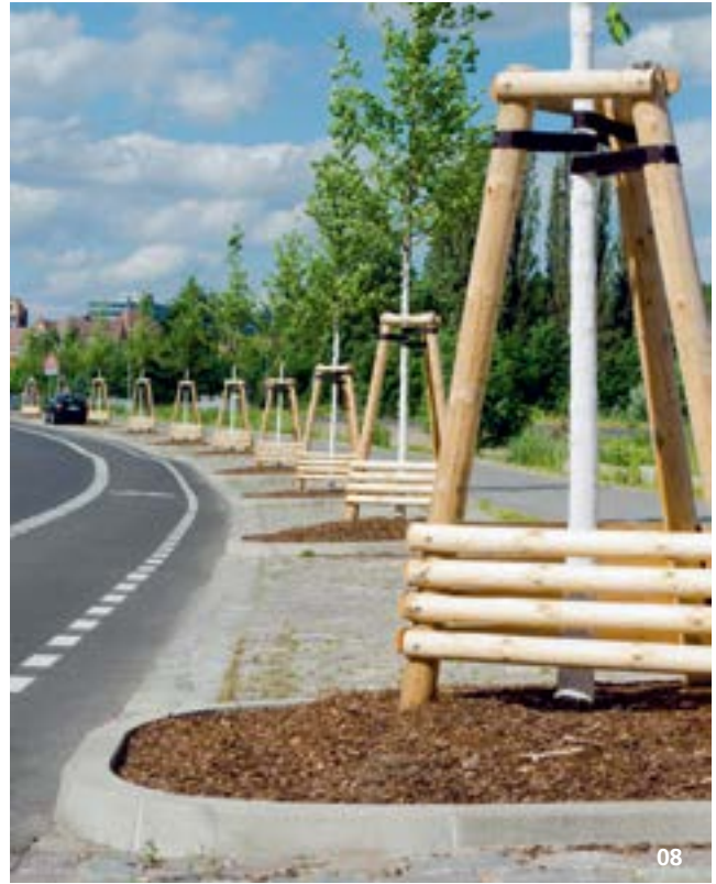
07/08 Kanallose Straße: Bepflanzte und versickerungsfähige Randstreifen nehmen die Niederschläge auf.
