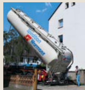
Die Auffüllung erfolgte schnell und staubfrei mittels Silo-Lkw und Schlauchleitung.
