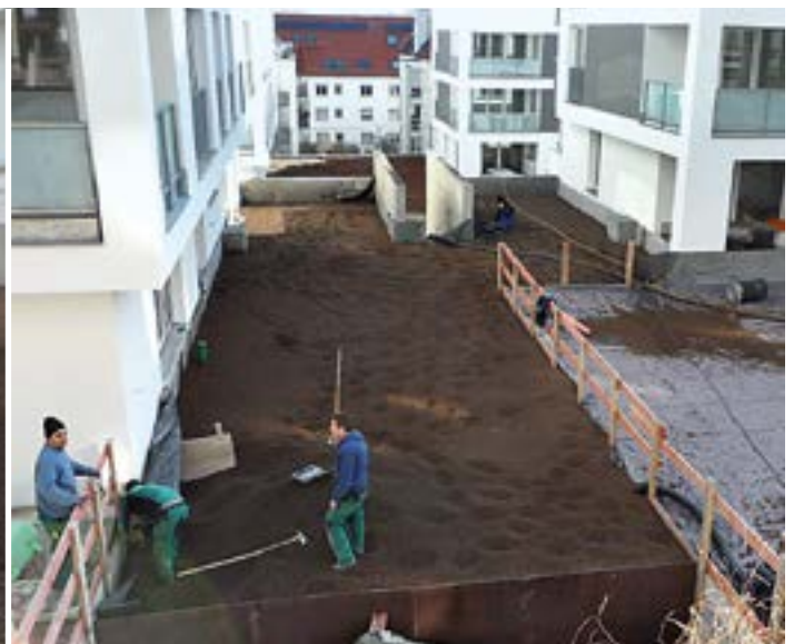
Der gesamte Eintrag erfolgte schnell und wirtschaftlich per Schlauchleitung – ohne Nachverdichtung, ohne spätere Setzungen.
