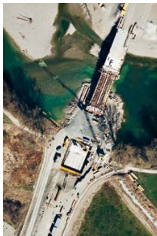
Unter der neuen Illerbrücke liegen rund 50 Meter mächtige, sandig- sowie tonig-schluffige Beckenablagerungen.
