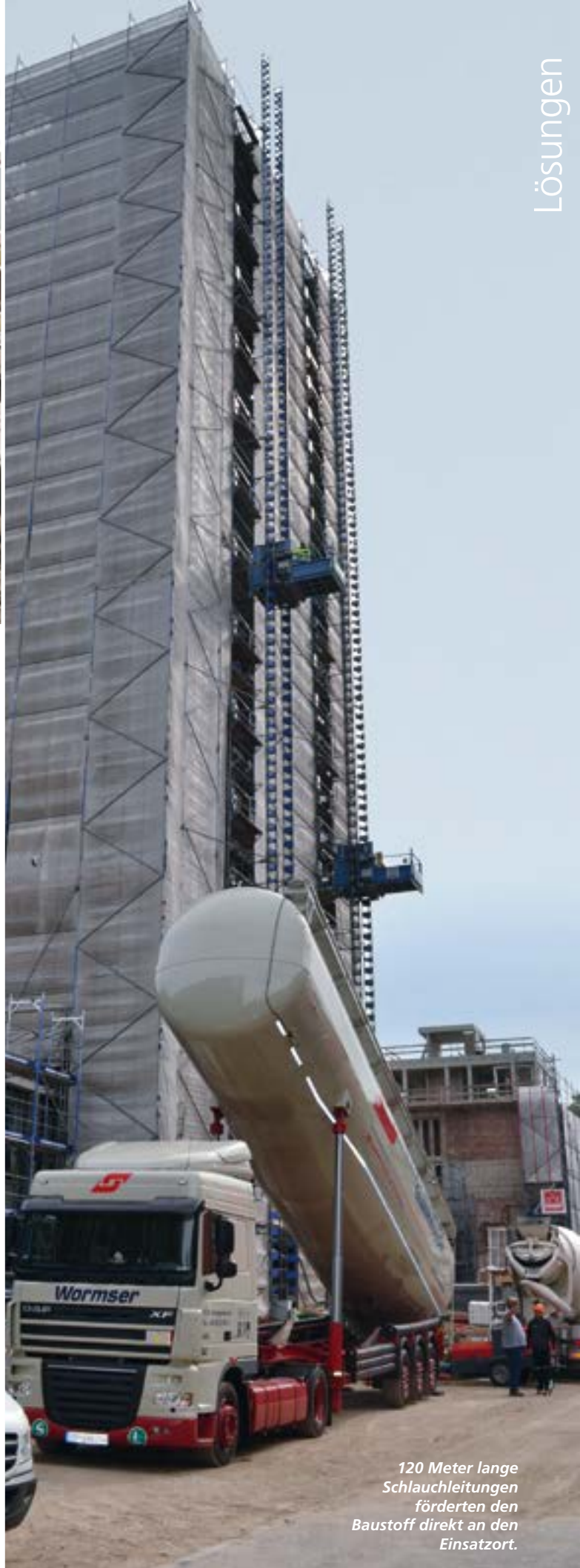
Der Fußbodenaufbau mit der Liapor-Schüttung erfolgte in jedem der 15 Stockwerke.
