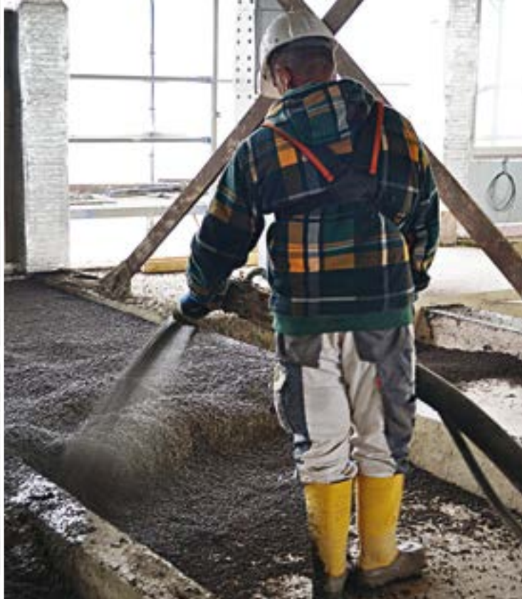
Der Fußbodenaufbau mit der Liapor-Schüttung erfolgte in jedem der 15 Stockwerke.
