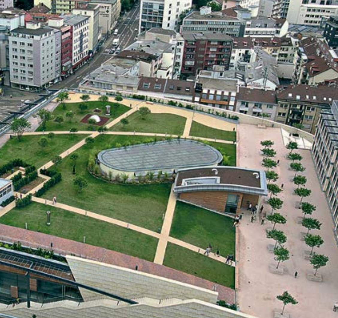
Die Begrünung von Dachflächen mit Liadrain als Wachstumssubstrat hat sich vielerorts, wie hier in Pforzheim (oben), bestens bewährt.
