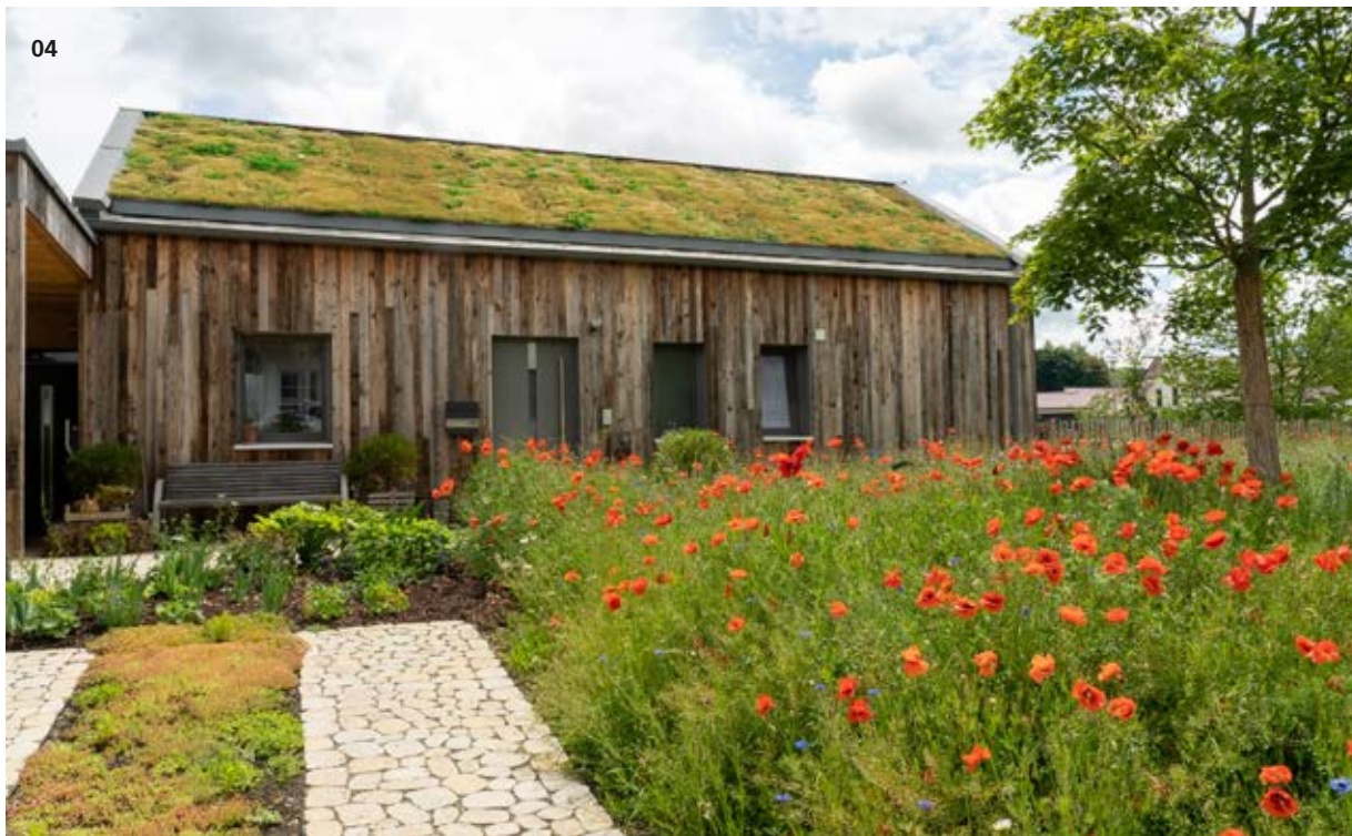
04 Bepflanzte Flächen wie Gründächer kühlen die Umgebung, binden Staub und Schadstoffe und beugen Überflutungen vor.
